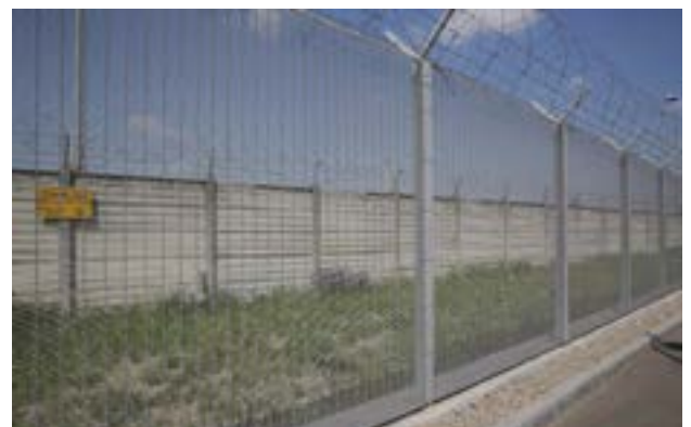
Poteau OMEGA 60x40x25x3 ou 120x60x30x3 mm
